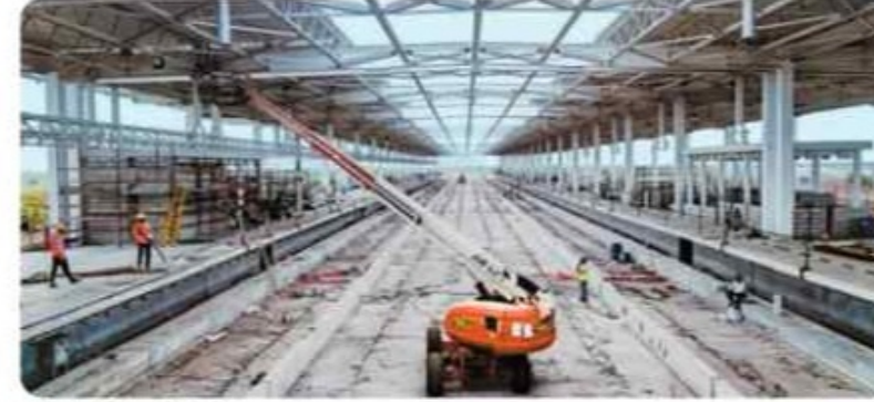
प्लेटफॉर्म का निर्माण पूरा।
